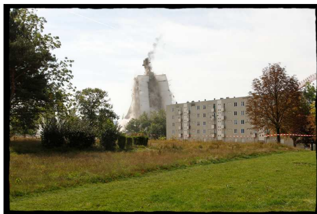
Semi foudroyage de la tour aux Mureaux le 3 octobre 2010
